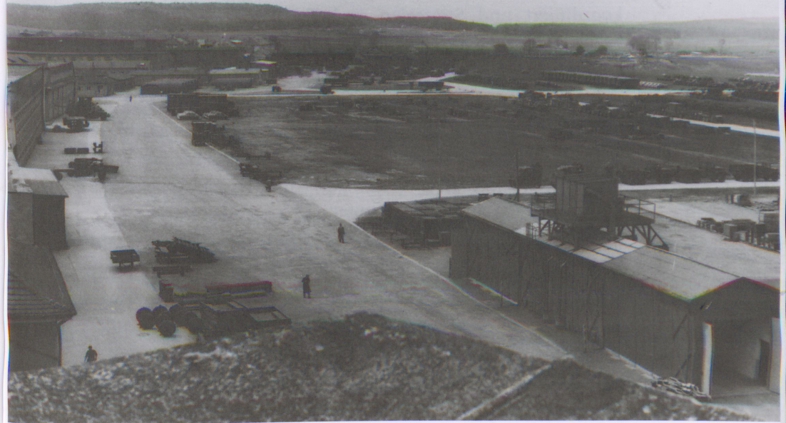
Das neu errichtete Reparaturwerk der Amerikaner, das auf dem Gelände des ehemaligen Militärflugplatzes eingerichtet wurde.
