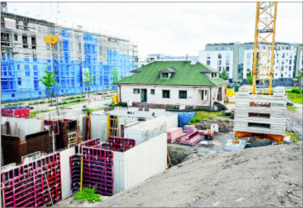
Obwohl erst gestern Spatenstich war, sind die Arbeiten der Erweiterung des historischen Empfangsgebäudes bereits weit fortgeschritten - die Wände des Untergeschosses ragen bereits in die Höhe. Der Holzblockbau im Hintergrund wird parallel denkmalgerecht saniert
